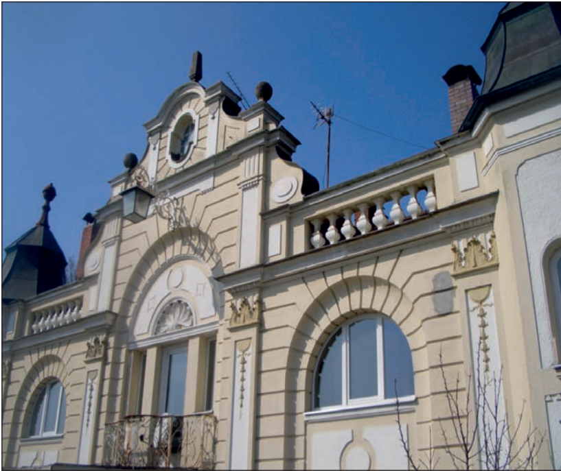
Aufnahme (März 2012) der Isarfassade vor ihrer Sanierung. (Foto: Anja Botzet)
