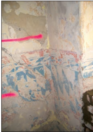
Während der Sanierungsarbeiten (2012) freigelegtes Rautenmuster im Inneren des Ussar-Anwesens. (Foto: Anja Botzet)
