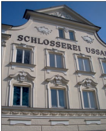
Aufnahme (März 2012) der Süd-West-Fassade des ehemaligen Gerl'schen Wohnhauses bzw. heutigen Ussar-Hauses vor ihrer Sanierung. (Foto: Anja Botzet)
