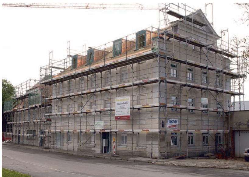
Sanierungsarbeiten am Hauptgebäude.
