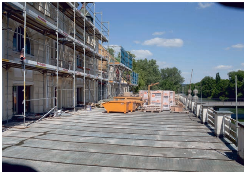
Die Terrasse während der Sanierung.
