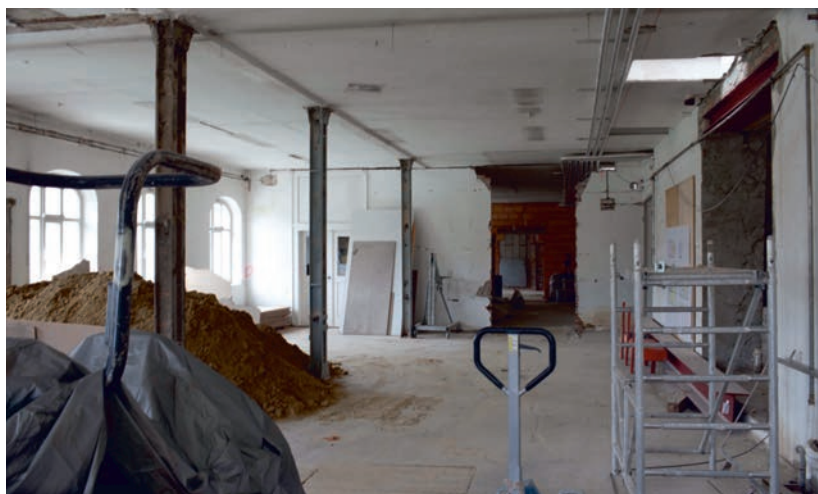
Beginn der Umbauarbeiten im Erdgeschoss.
