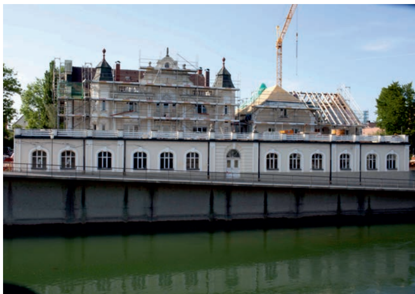
Sanierungsarbeiten an der Fassade.
