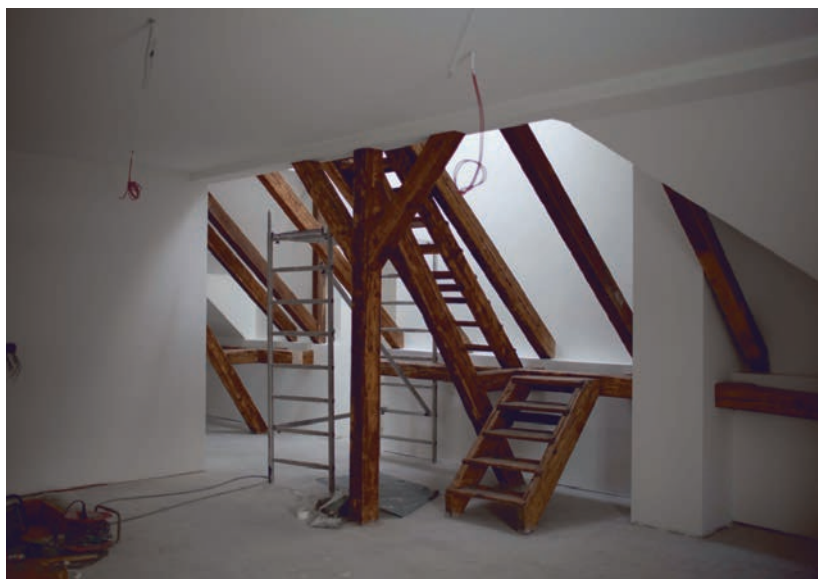
Abschlussarbeiten im ersten Obergeschoss.
