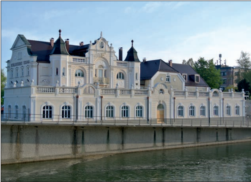
Außenansicht des fast fertigen Ussar-Hauses im Mai 2013. (Foto: Christian Steer)
