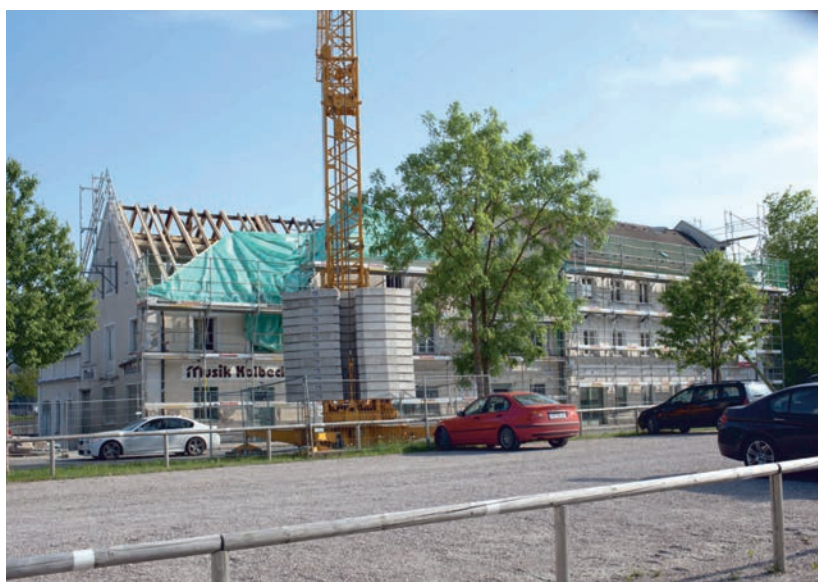
Außenarbeiten zu Beginn der Sanierung.
