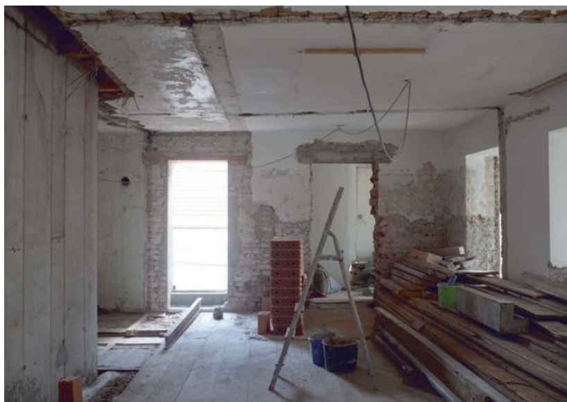
Abschluss der Rohbauarbeiten im zweiten Obergeschoss.
