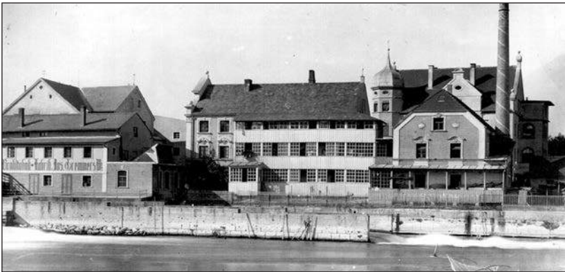
Die „Brasiltabak-Fabrik Jos. Gremmer's Ww.“. Zu sehen ist der Anbau zur Unterbringung eines Gasmotors (links), das ehemalige Gerl'sche Wohnhaus mit neu gestalteter Fassade (mittig) und der „Neubau“ (rechts). Die Fotografie wurde vermutlich zwischen 1897 und 1902 aufgenommen. (Foto: Privatbesitz)
