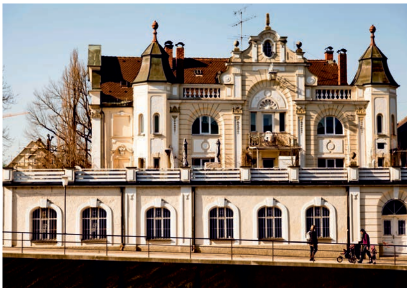
Die Zierfassade vor der Sanierung.
