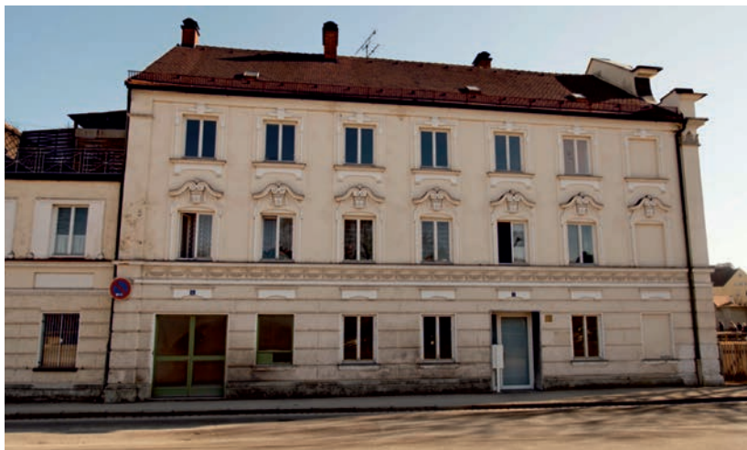
Das Hauptgebäude vor der Sanierung von der Straßenseite her gesehen.
