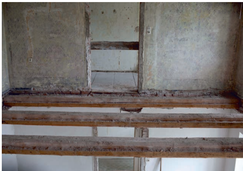
Entstehung des neuen Treppenhauses.
