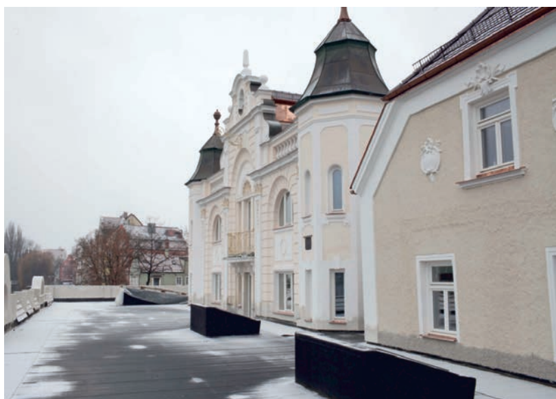
Die sanierte Terrasse im Winter.
