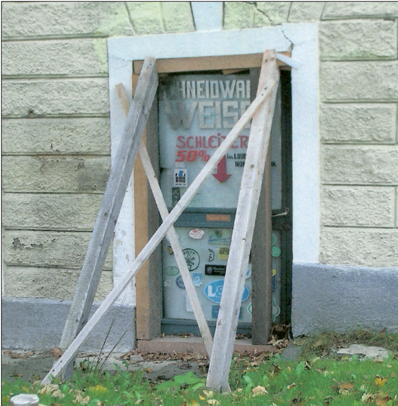
Der Eingang von „Schneidwaren WEISS“. Das Bild wurde kurze Zeit vor dem Abbruch der Schleifmühle im Jahr 2009 aufgenommen. (Foto: Max Weiß)
