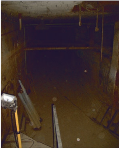
Blick in den Triebwerkskanal. Die Aufnahme entstand während der Sanierungsarbeiten im März 2012. (Foto: Anja Botzet)
