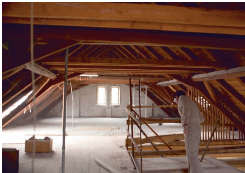
Beginn der Umbauarbeiten im Erdgeschoss.
