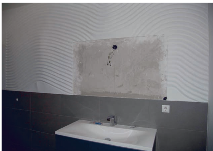
Endarbeiten an der Wellenwand im Badezimmer des ersten Obergeschosses.
