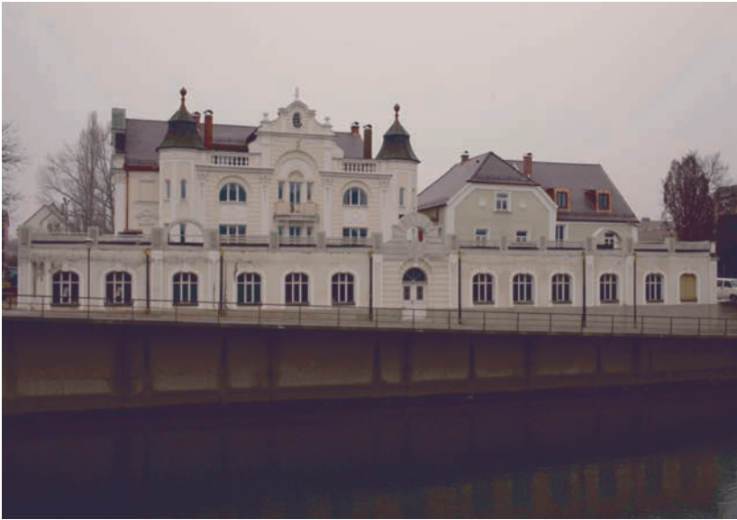
Die Fassade nach der Sanierung.
