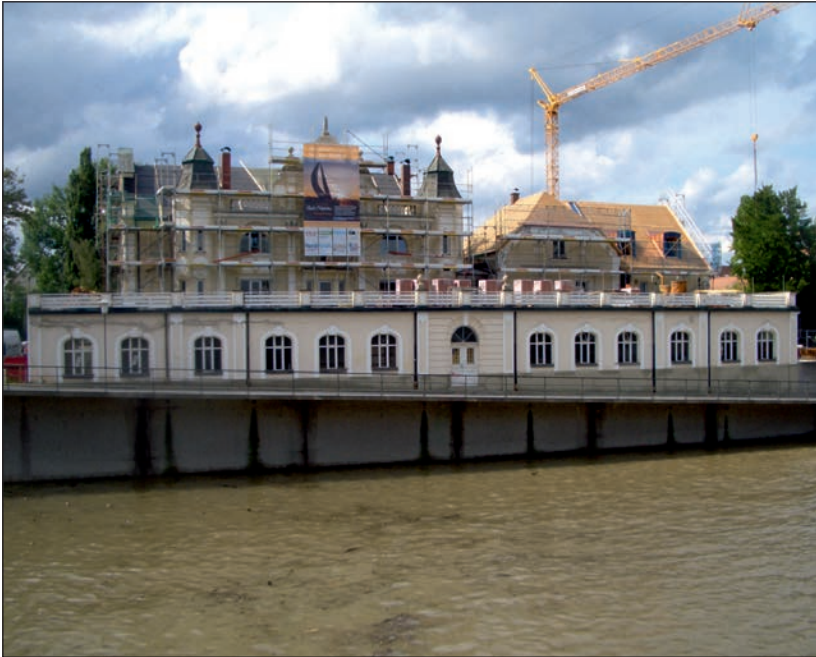
Blick auf die Isarfassade des Ussar-Anwesens während der Sanierungsarbeiten im Juni 2012. (Foto: Anja Botzet)
