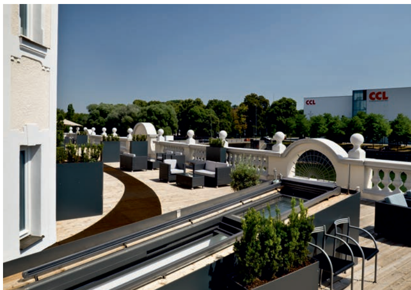
Die Terrasse nach der Sanierung.
