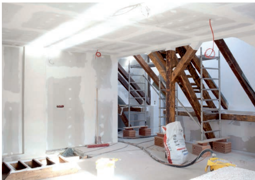
Trockenbau im ersten Obergeschoss.
