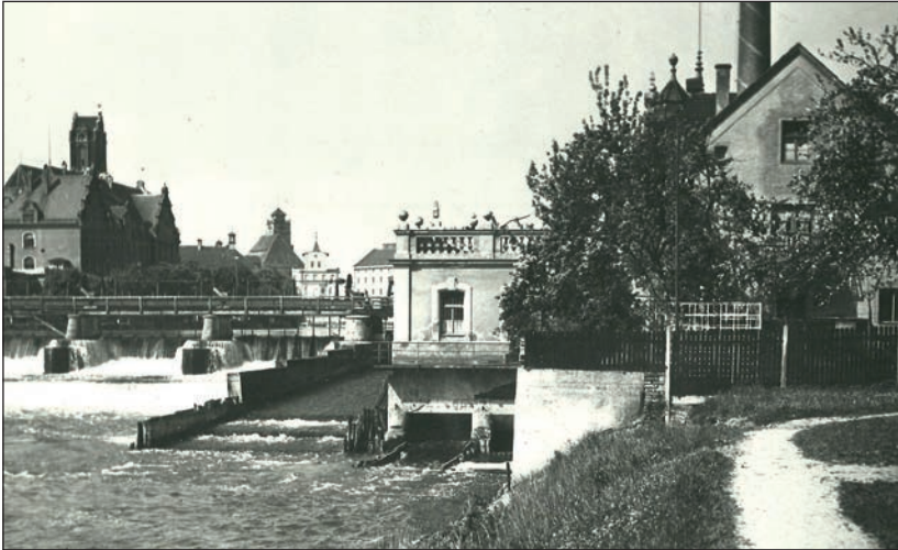
Ansicht des Usar-Anwesens auf die seitliche Gartenfassade mit Floßgasse, Triebwerkskanal und Leerschuss (von links nach rechts). Im Hintergrund ist das frühere Maxwehr zu sehen. Die Aufnahme entstand vermutlich in den 1930er-Jahren. (Foto: Heribert Dettenkofer)
